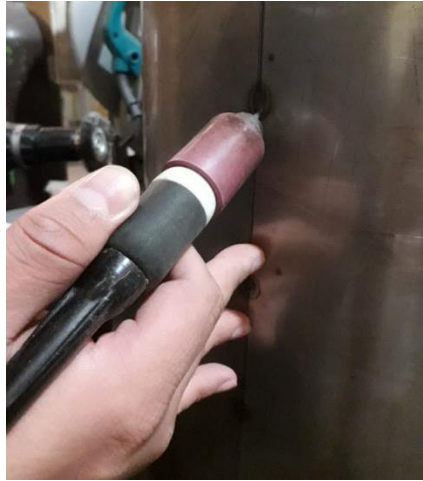
Figura 12. Soldadura con TIG en tolva
